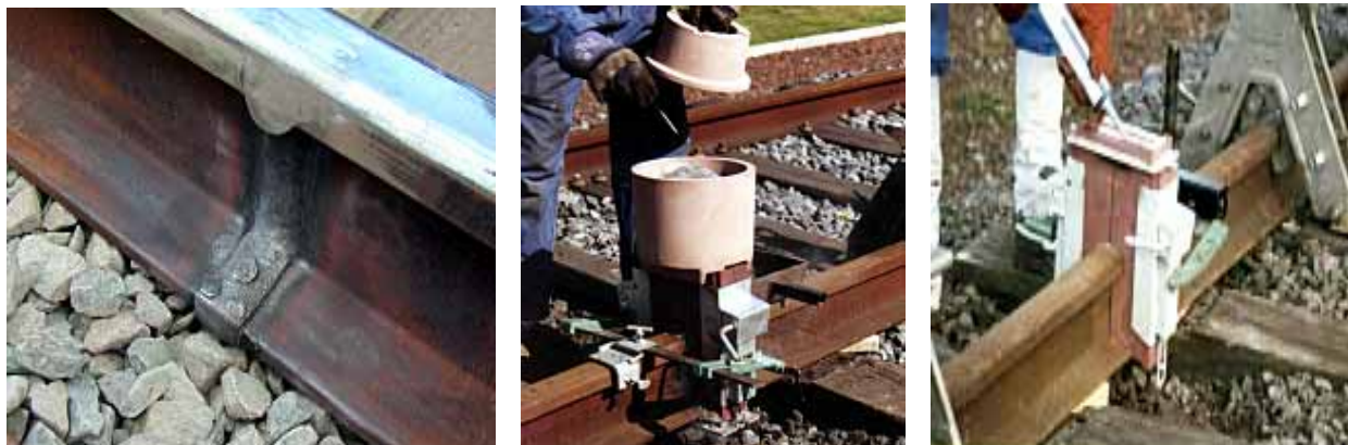
شکل ۲ - جوش درز ریل [۱۱، ۹]
